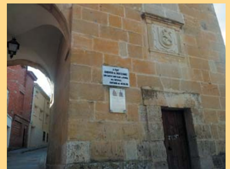
Situación del antiguo panel en la Torre del Reloj
